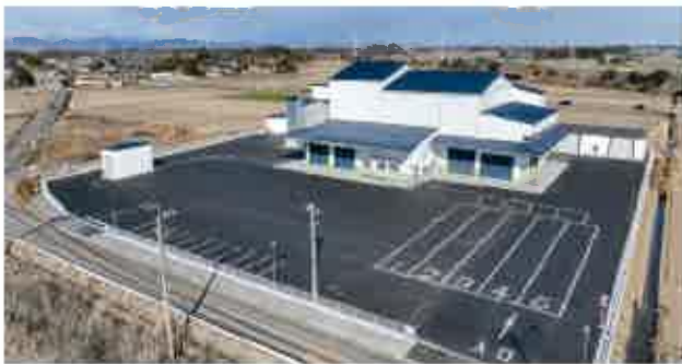
南部地区ライスセンター
